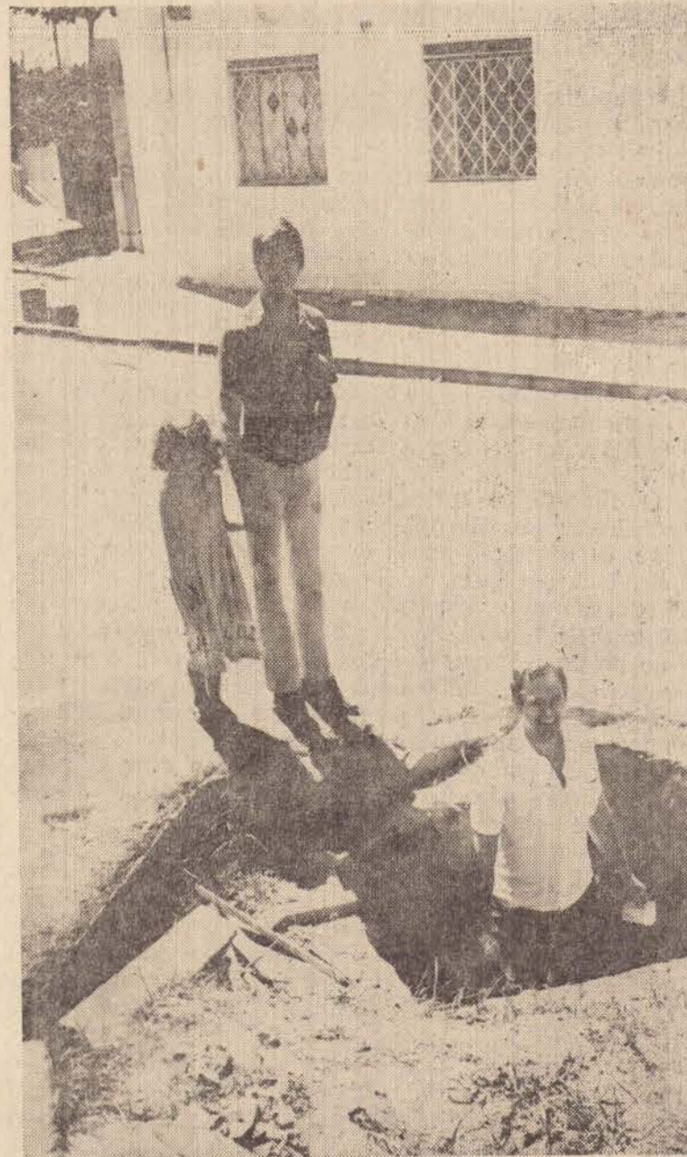
Pedestres e veículos, já caíram neste buraco.
