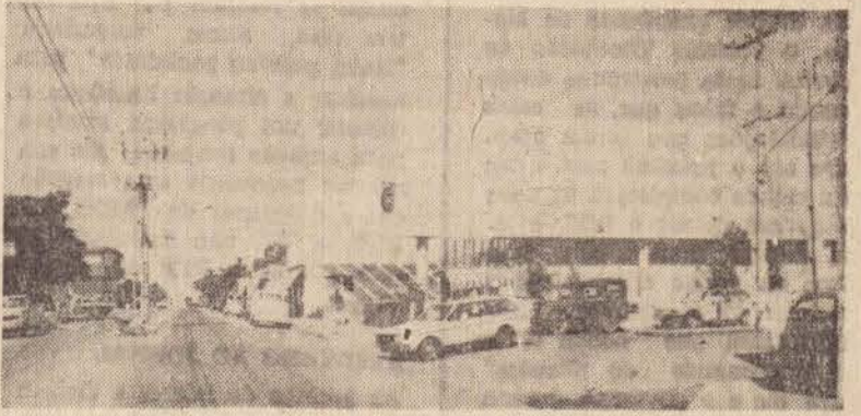
Predio da Caixa Estadual
