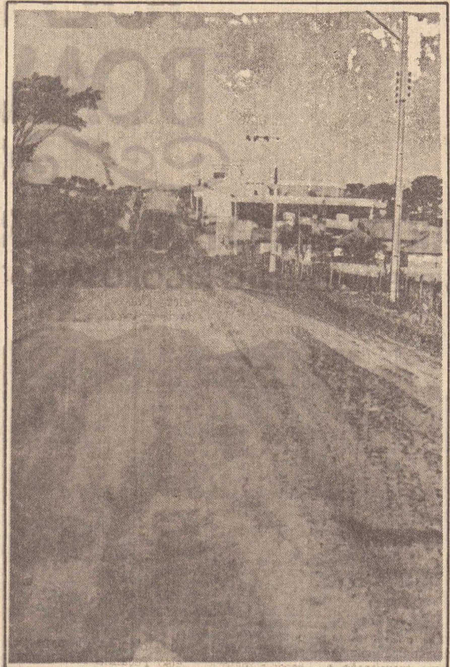
Várias empresas já estão em funcionamento ao longo da avenida e serão diretamente beneficiadas pela pavimentação.
