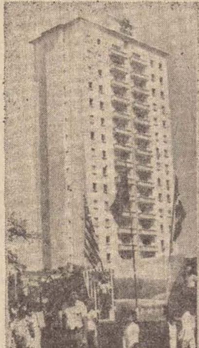
Edifício "Portal da Catedral" Rua Barão do Rio Branco, 703 19 pavimentos 32 apartamentos 45 boxes-garagem área construída: 8.050,50 metros quadrados (já concluído)
