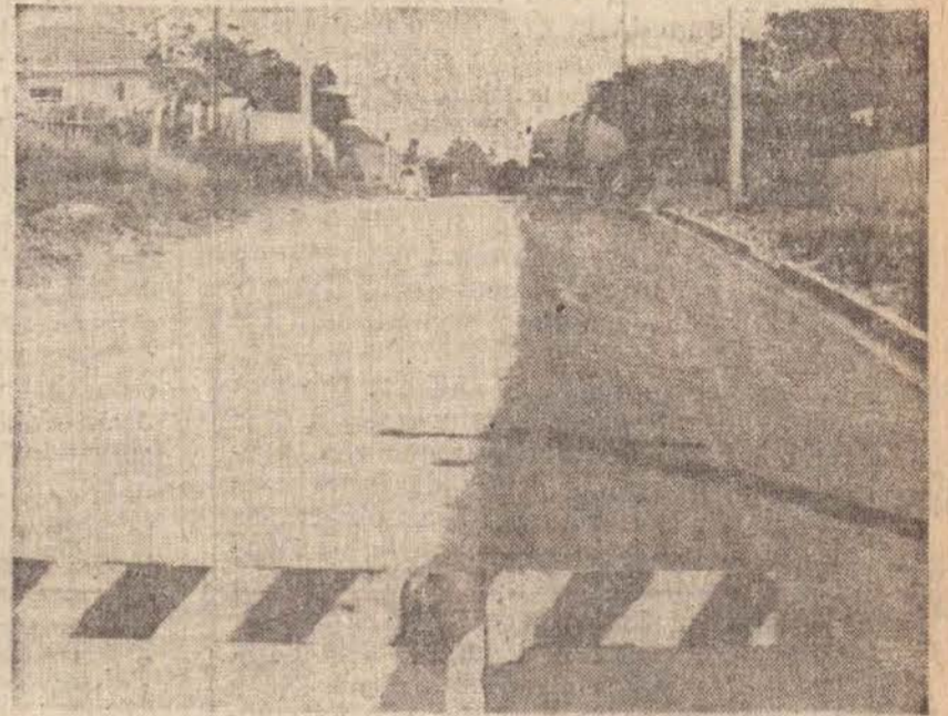
Na Vila Malaman a pavimentação já está chegando ao final.
