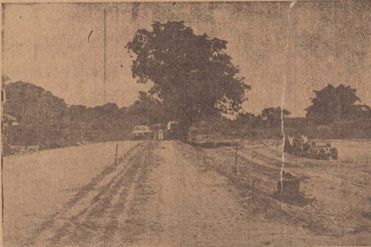
Trecho da rua 15 de Maio, preparado para pavimentação, vendo-se ao fundo uma grande arvore a ser preservada
