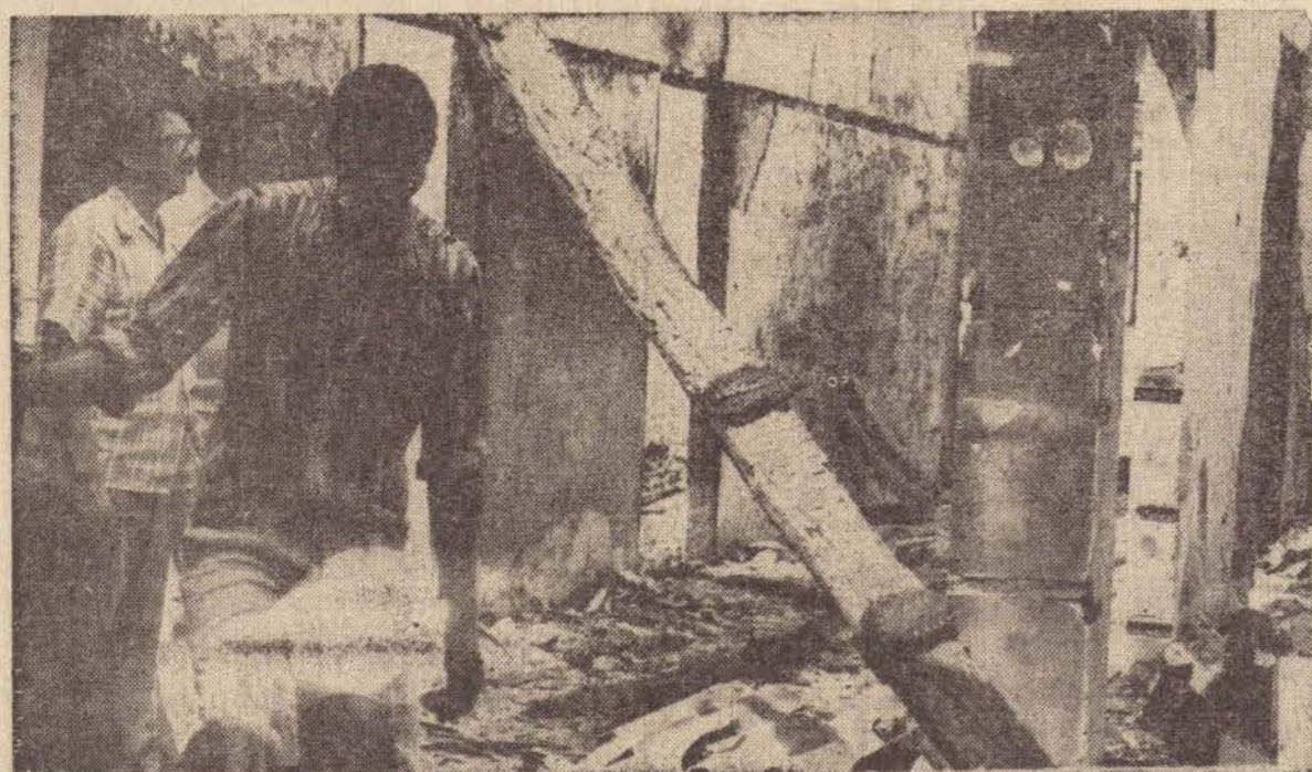
Embora totalmente destruído, o prédio da prefeitura, o sinistro deixou um rastro de crime que agora será apurado.
