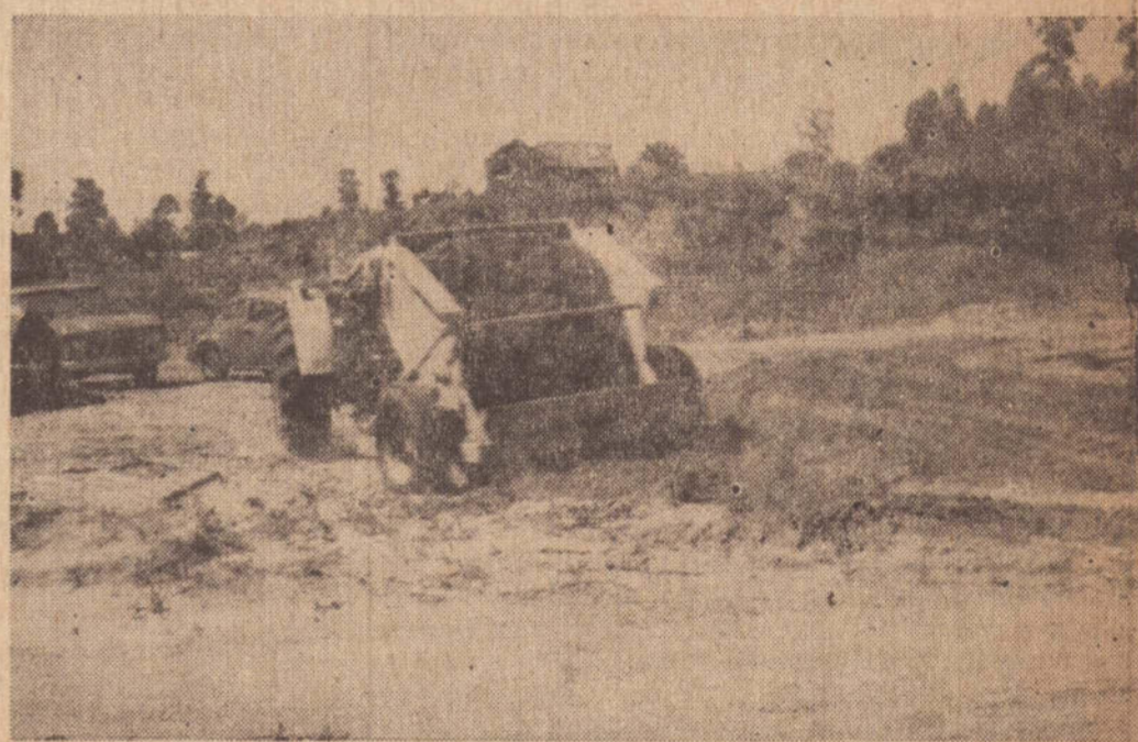
Um trator CBT conduz um SCRAPER para a demonstração de sua eficiência na construção de açudes, represas, barragens e conservação de estradas
