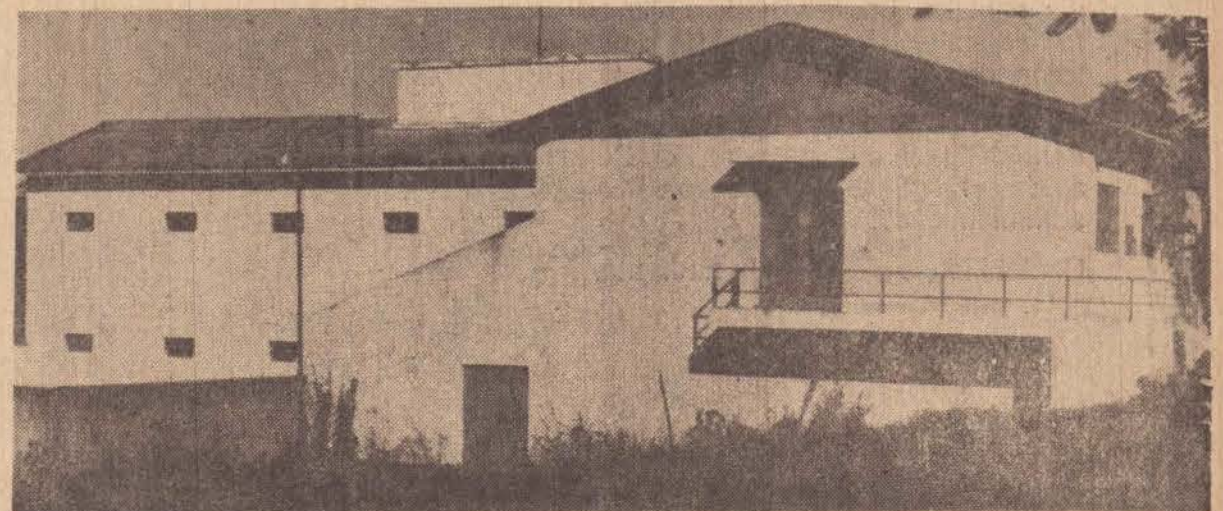
No Parque do Povo, um prédio sem qualquer destinação.
