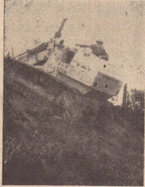
Esta máquina em poucos minutos rompeu um paredão e escalou-o em direção à linha da estrada que fará conexão com a Avenida Washington Luiz.
