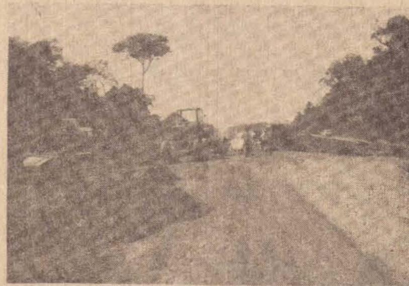
As obras da ligação Nova Andradina-Casa Verde estão caminhando agora rapidamente.
