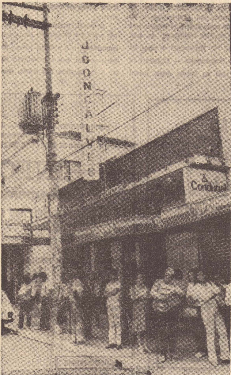
A fachada das atuais instalações da J. Gonçalves, na Avenida Brasil
