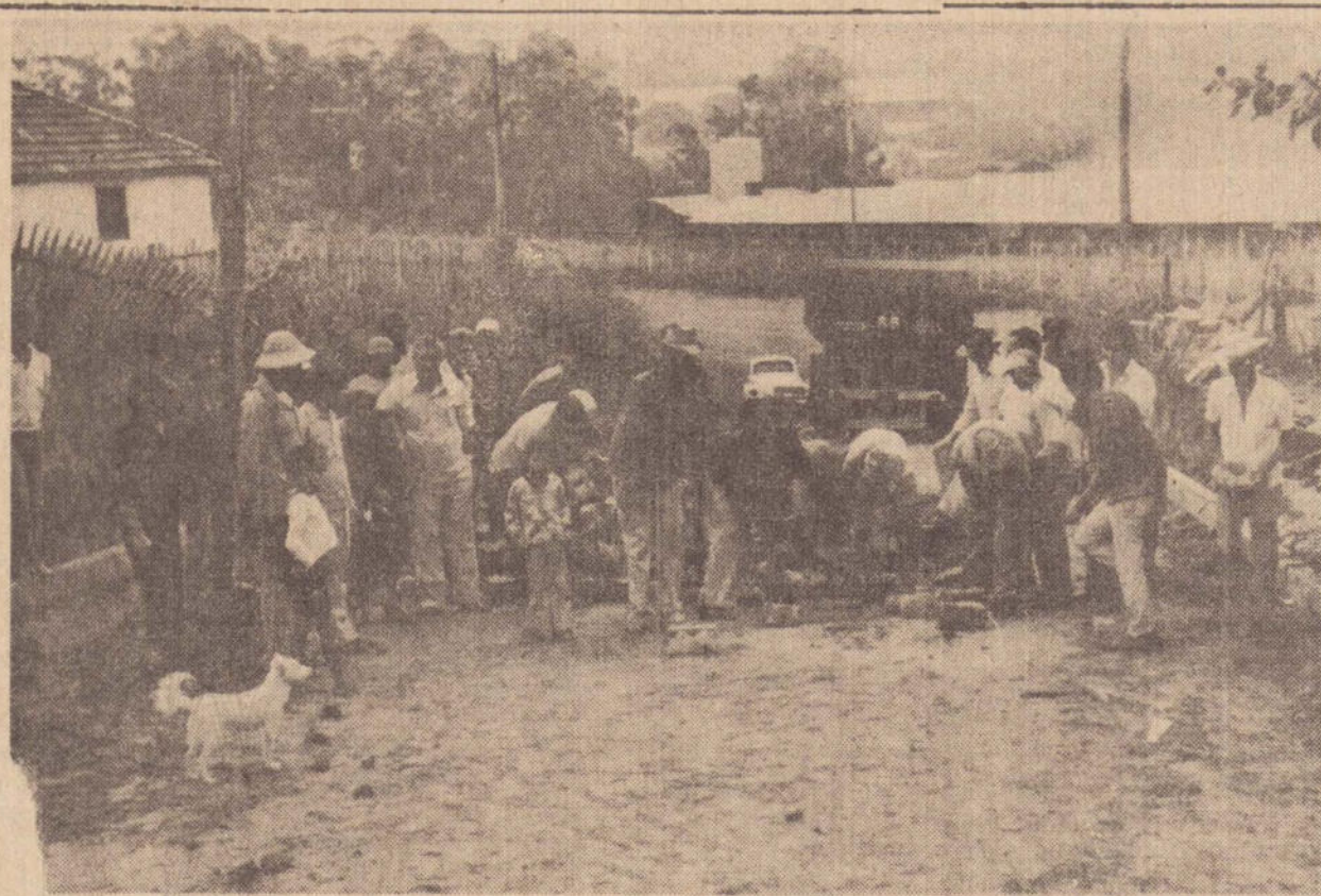
A rua que liga o bairro à rodovia Raposo Tavares é que está sendo calçada inicialmente
