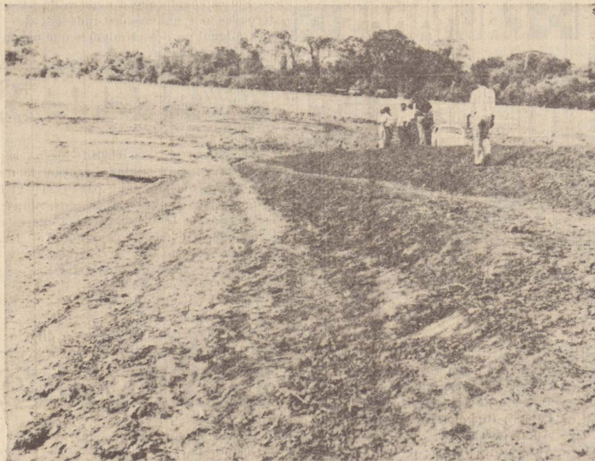
Um aspecto da barragem que está sendo erguida para represar o Limoeiro, no futuro Balneário da Amizade.
