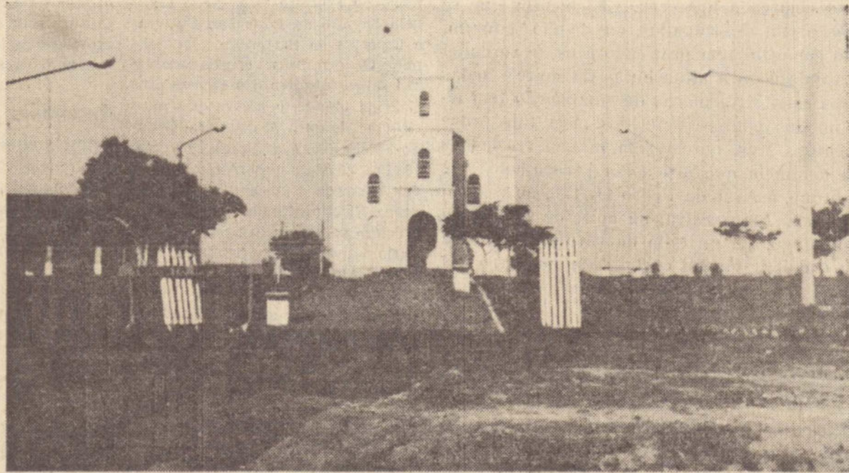
Um aspecto da nova praça da igreja de Eneida, já em fase de conclusão.
