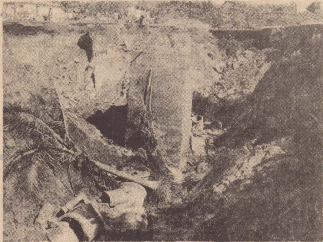
A erosão pluvial deixou Mirante do Paranapanema incomunicável, nos últimos dias.
