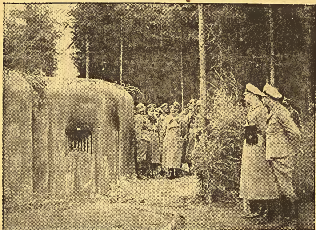
Der Führer besichtigt die Schöberlinie. — Auf seiner Fahrt durch das Rumburger Land besichtigte Adolf Hitler die Schöberlinie, die ausgeleitete Befestigungslinie, die die Tschechen in den letzten Jahren entlang der Reichsgrenze errichtet hatten.
