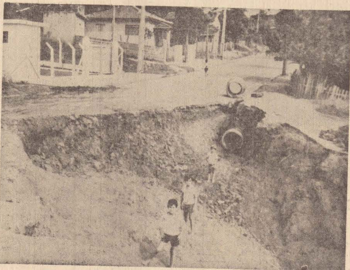
Até as galerias pluviais estão sendo destruídas
