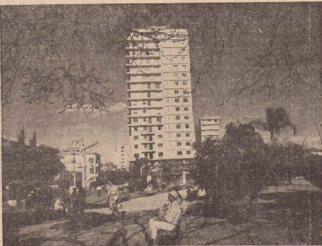
Vista da Praça Nove de Julho, vendo-se em destaque o canteiro central que será dotado das instalações sanitárias. PAGINA 2
