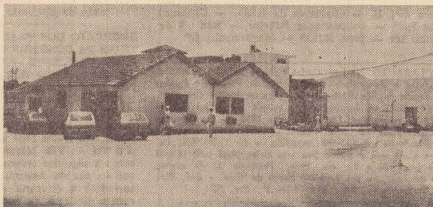
Um aspecto das antigas instalações do Abatedouro Anastaciano Ltda.
