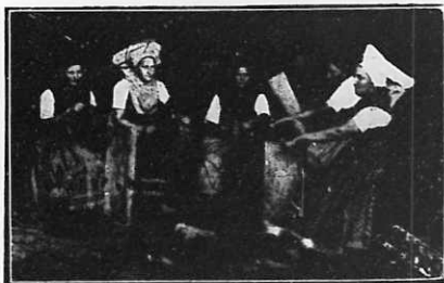
Operação de alisar e equalar as fibras do linho.
