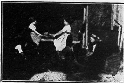
Manipulação domestica do linho num aparelho destinado a estender as fibras
