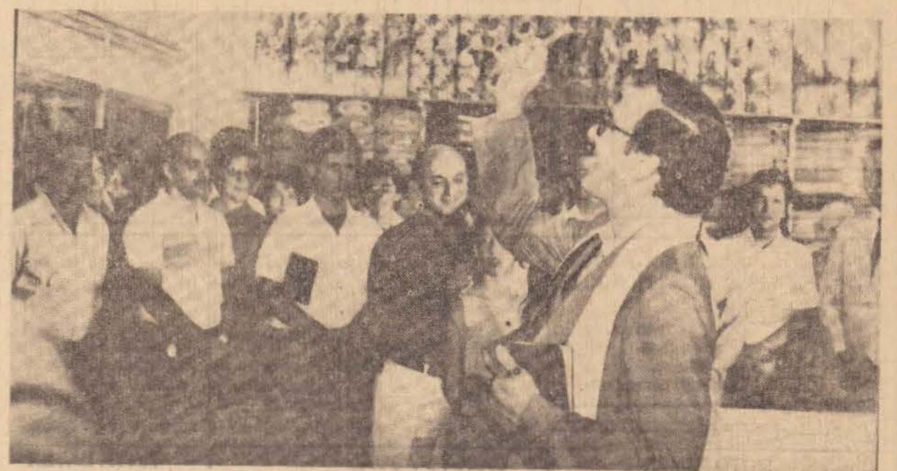
Padre Jerônimo Gasques procedendo a bênção das instalações
