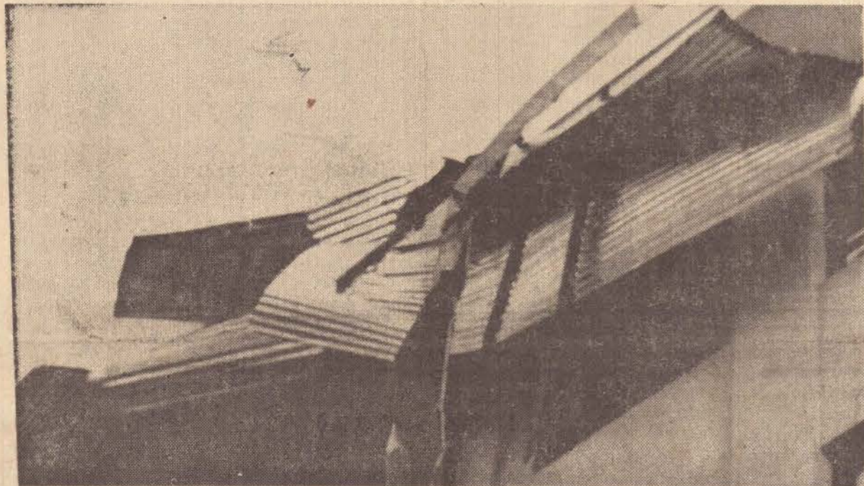
As telhas de alumínio ficaram inteiramente retorcidas.
