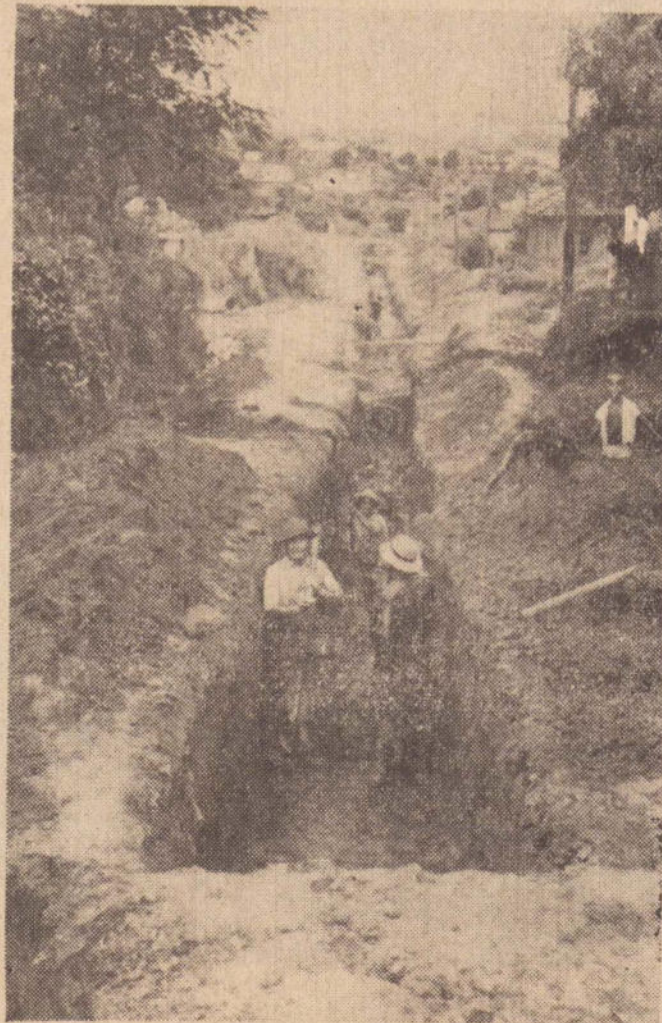
Obras como esta da R.D. Pedro II, a Prefeitura está executando em vários locais.
