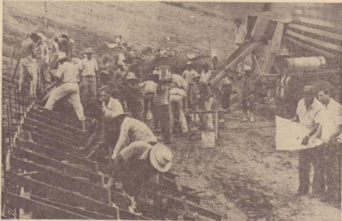
Dirceu Matheus e Antonio F. Lima (Biguá) inspecionam as obras.
