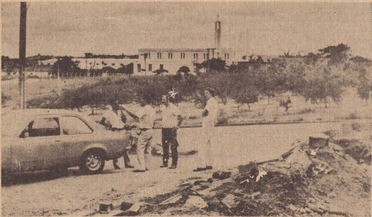
O novo prédio está em construção diante da Praça das Cerejeiras
