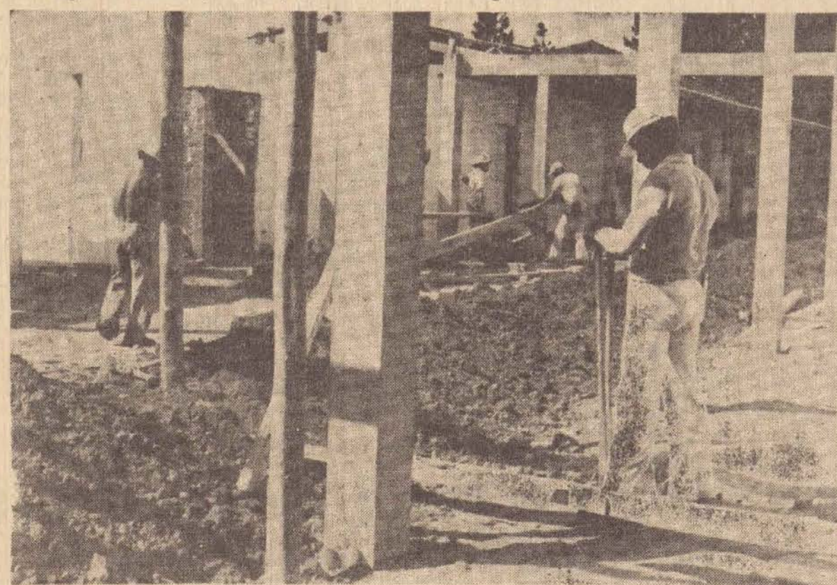
Mais três pavilhões estão sendo construídos pela prefeitura municipal
