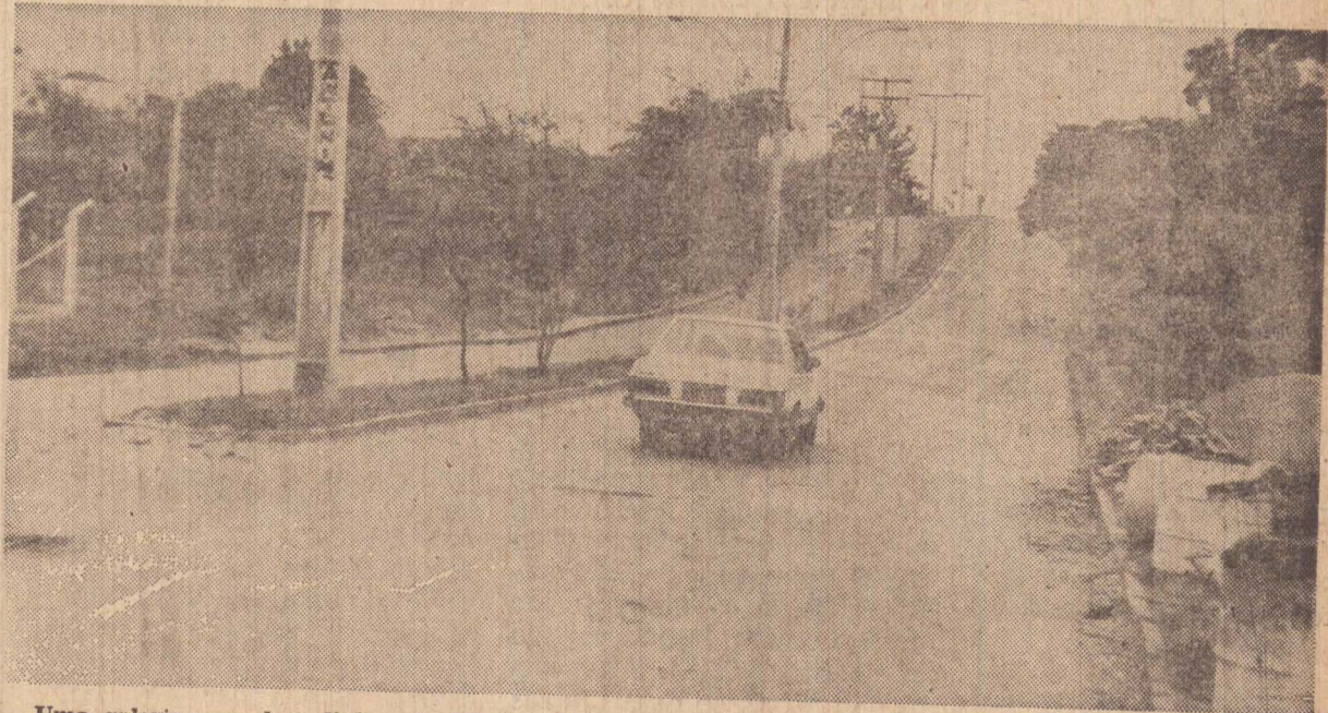
Uma galeria com duas linhas de tubos ovóides foi construída pela Prudente na altura do Córrego da Colônia Mineira
