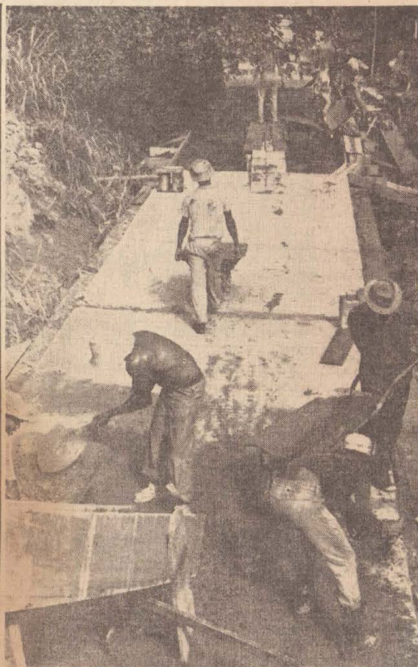
Uma grande galeria está interligando a rede pluvial, como parte do Projeto “Cura” que beneficiará centenas de moradores das ruas Emilio Mori, São Sebastião e as transversais a partir da rua Julio Prestes até Joaquim Paulista.
