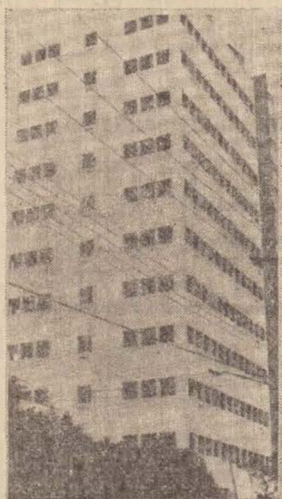
Edifício "Centro Médico-Odontológico" Av. Washington Luiz, 874 12 pavimentos 40 apartamentos 40 boxes-garagem área construída: 3.364,99 metros quadrados (empreendimento em obras) unidades à venda previsão de entrega: fevereiro de 1980
