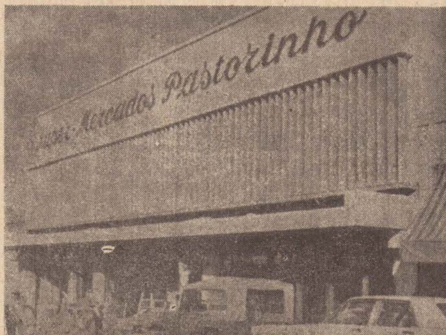
A magnífica fachada do Supermercado Pastorinho será um detalhe a mais a enriquecer o aspecto comercial do centro urbano.
