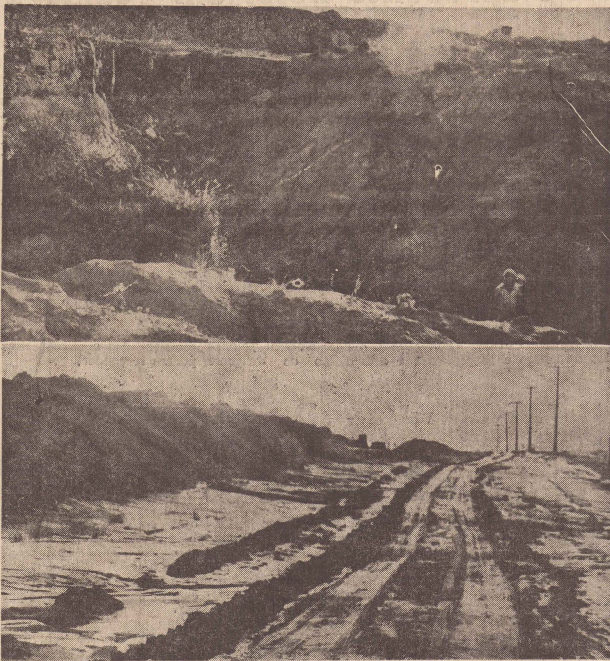
A erosão já ameaça a via principal do Distrito, que se torna intransitável após a chuva; por menor que seja
