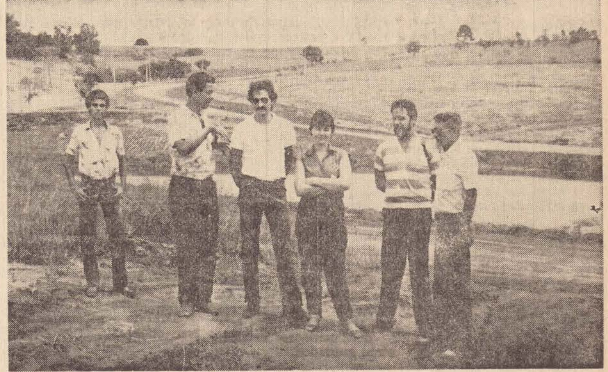
Claret Leite Oliveira e os funcionários do departamento de vendas de TERRAS DE IMOPLAN, visitando as obras no loteamento.
