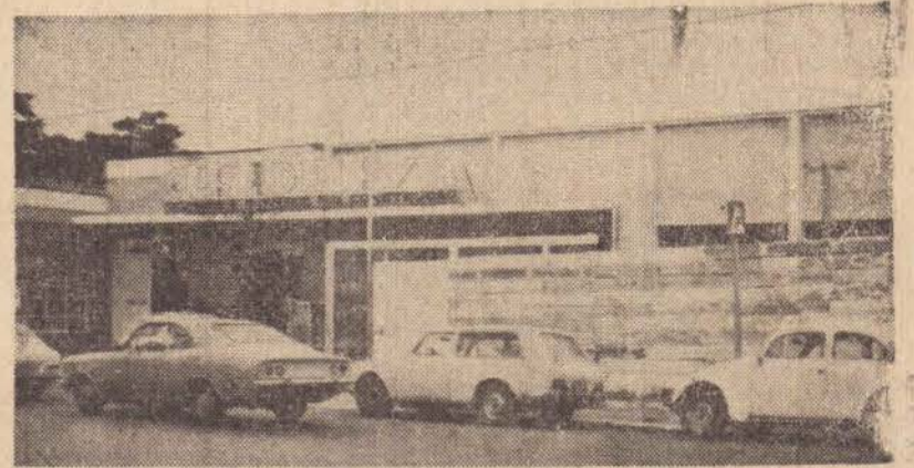
A loja, atualmente com alguns tapumes devido às obras de ampliação, terá sofisticado show room.
