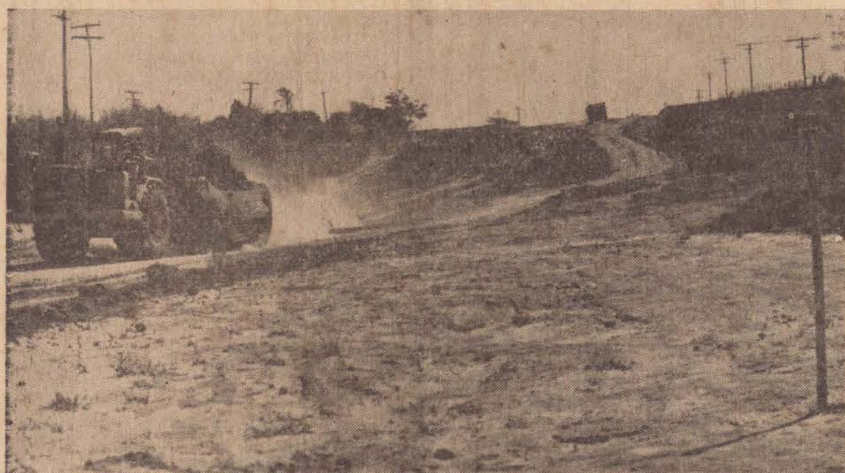
Estes serviços já fazem parte do lote de obras da pavimentação da Estrada da Amizade.
