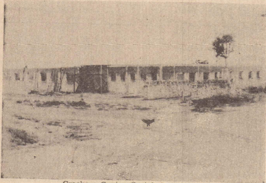
Creche e Centro Social, fase de reparos
