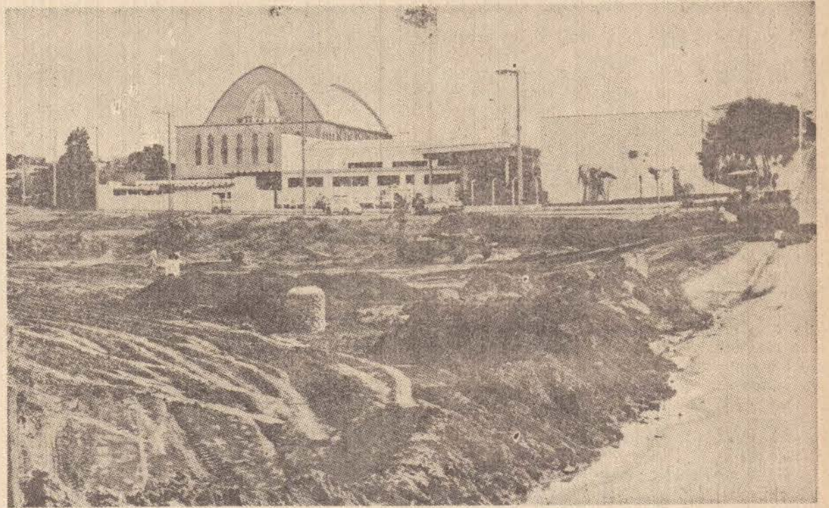
Na foto, aparece o serviço de aterro que está sendo feito na Av. Coronel Marcondes, solucionando o problema de espaço para a enorme rotatória.
