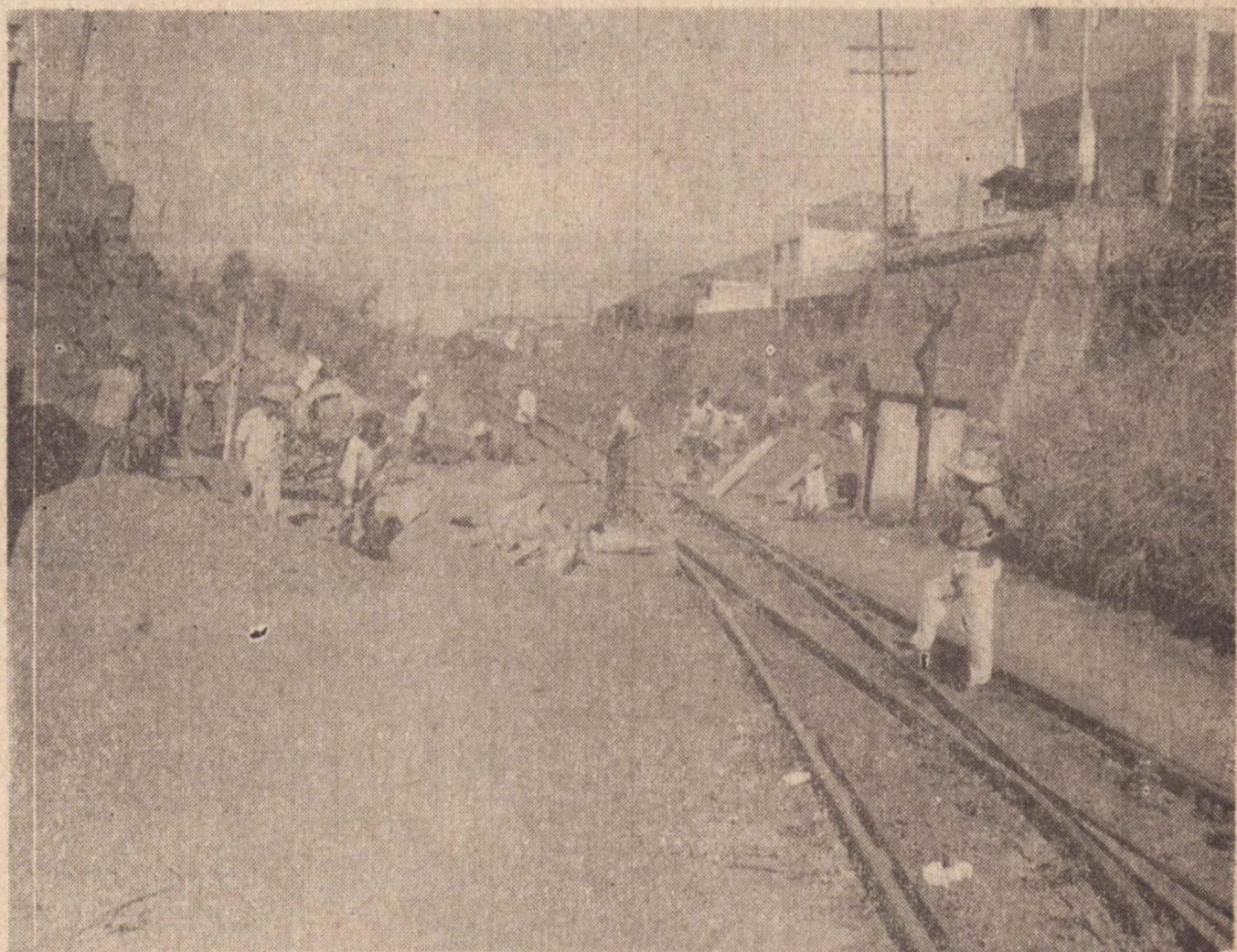
As máquinas e operarios da Prefeitura estão cavando uma elevação que ligará a Av. Brasil a uma Avenida Marginal que corre paralela à Raposo Tavares. Essa foi a solução encontrada para permitir o escoamento do trafego por essa nova via na Raposo Tavares.
