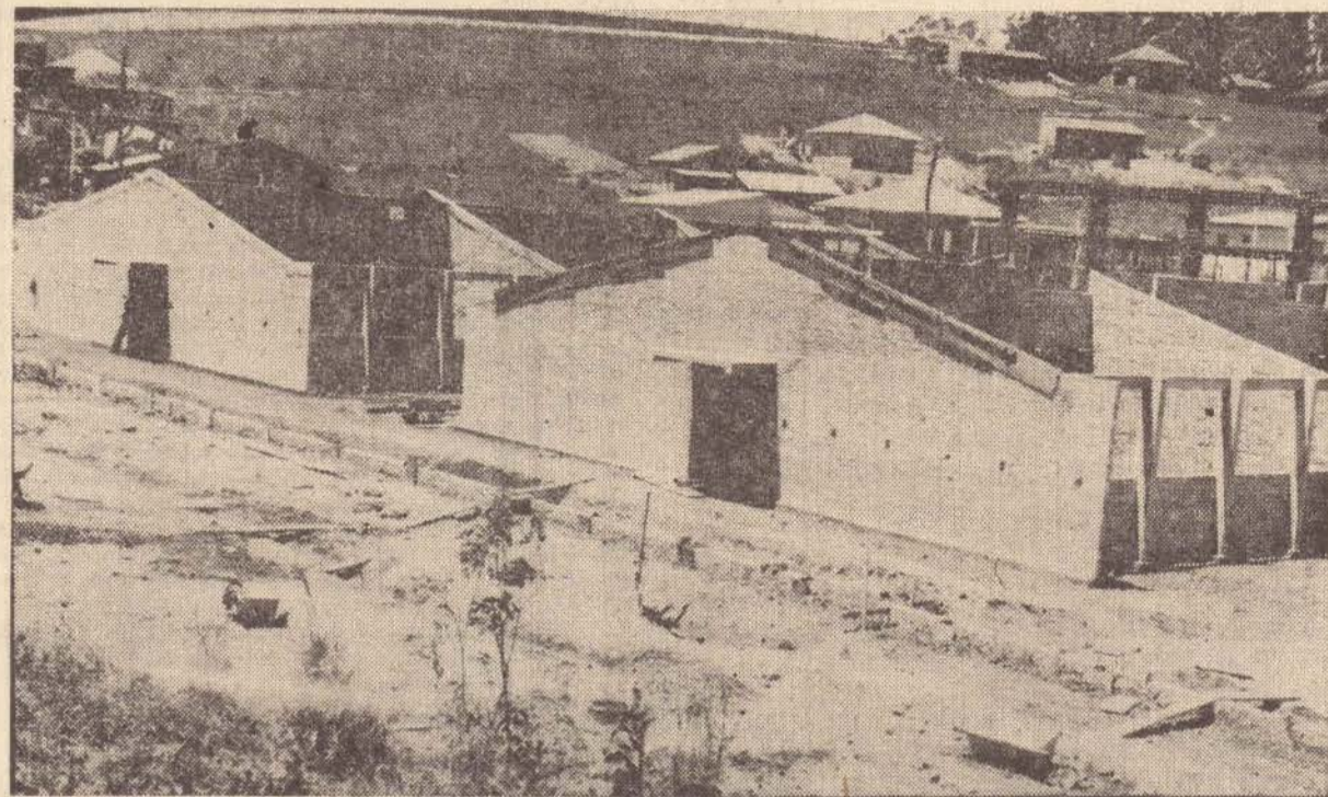
Este é o prédio da Esc. Estadual de 1.º Grau do J. Regina, em construção
