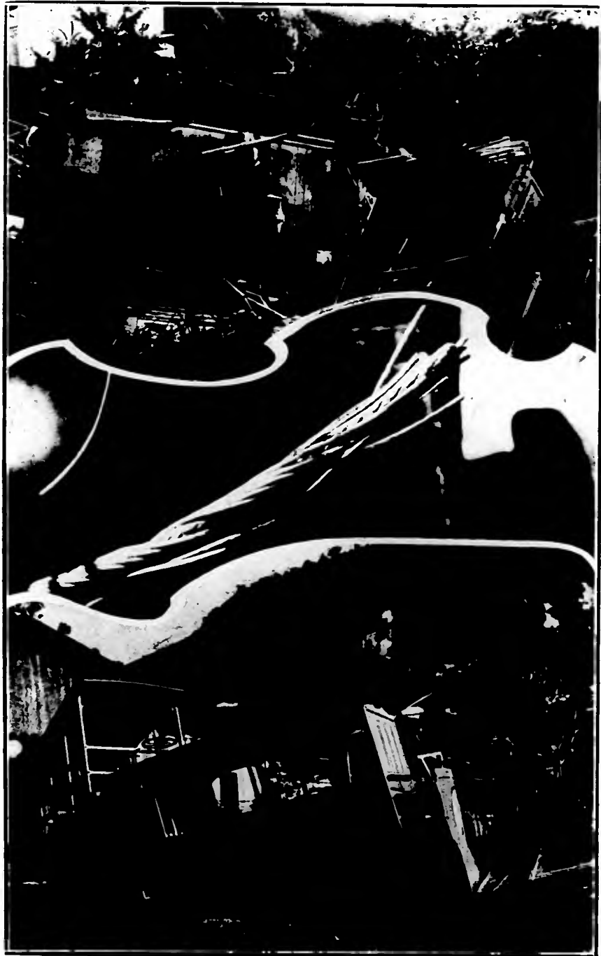
Em cima: O tramway que, por ter partido o cabo que o sustinha, rolou vertiginosamente sobre o plano inclinado que vai do Jabaquara a Nova Cintra, em Santos, occasionando a morte de duas pessoas e graves ferimentos em outras. No meio: o cabo que sustinha o ascensor e que arrebentou, causando o desastre. Em baixo: O tramway que accionava o trem que descia e que, partido o cabo, voltou á plataforma, ficando quasi em perfeito estado.
