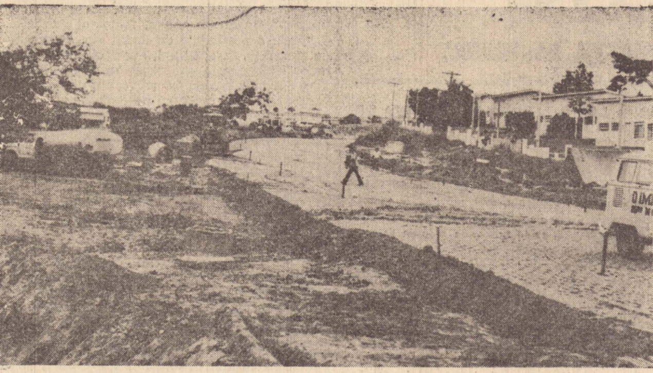
Uma pista, de 3 quarteirões, no núcleo BNH está com as obras bem adiantadas.
