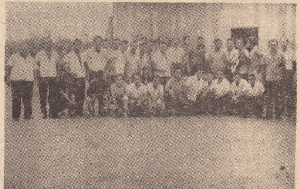
A equipe de operários que trabalharam na construção da linha, e que foram os maiores homenageados na oportunidade.
