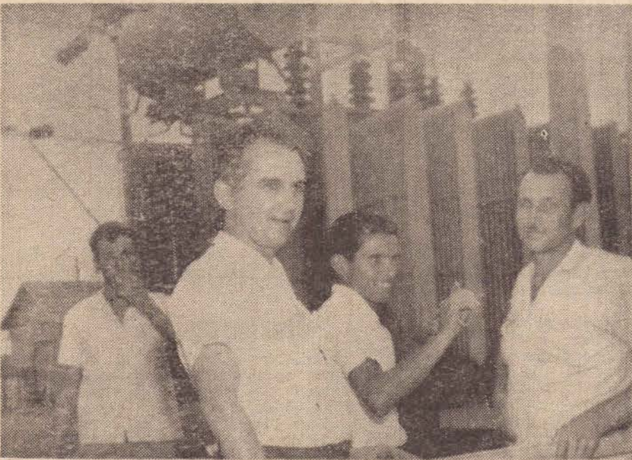
O prefeito de Adamantina, sr. Gumercindo Romanini, defronte ao transformador de 66/33/11-kV, na sub-estação de Adamantina.
