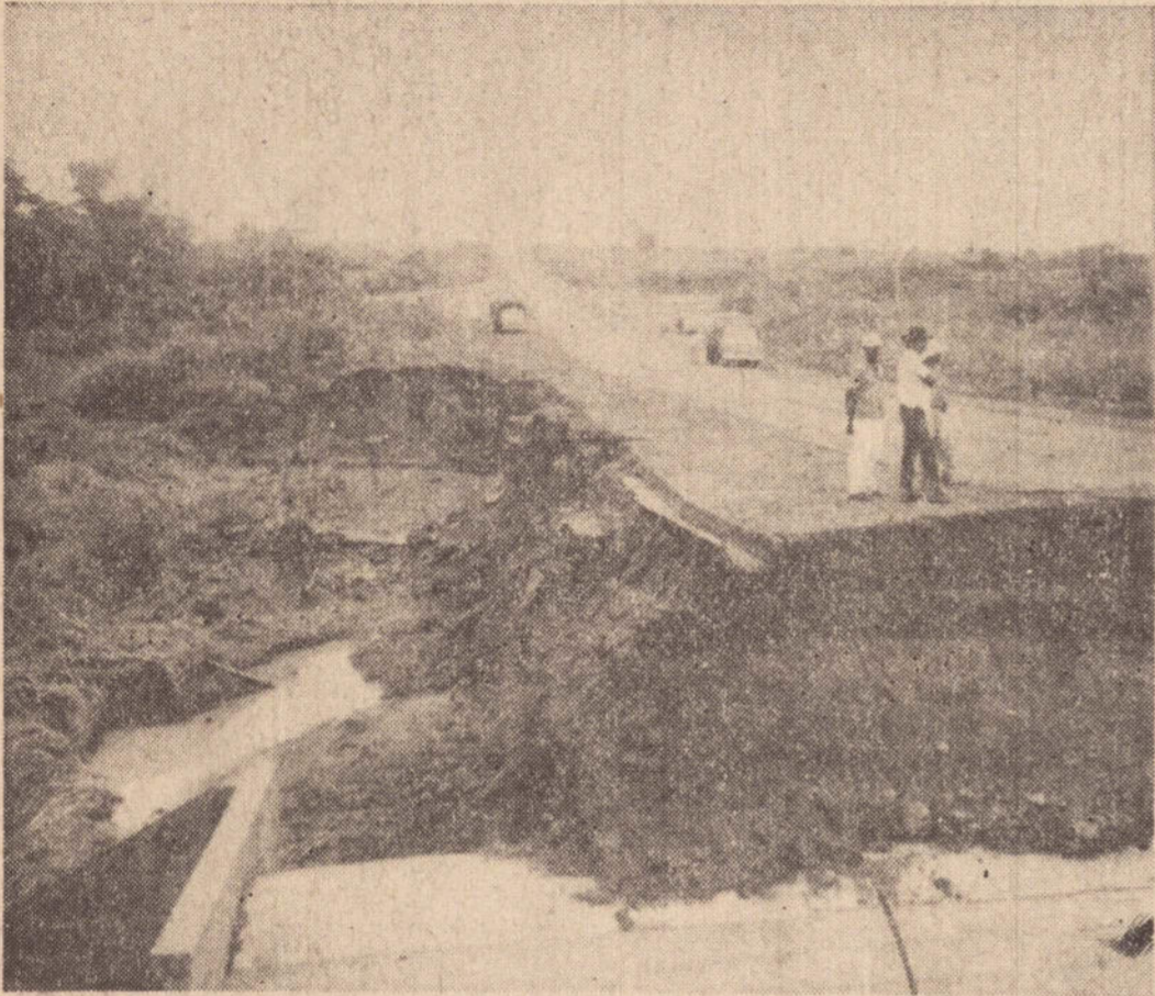
Depois de romper o aterro no km 586 da Rodovia Raposo Tavares as águas começaram a solapar o outro lado da pista, como se vê na foto, tirada no sentido Prudente-Bernardes.
