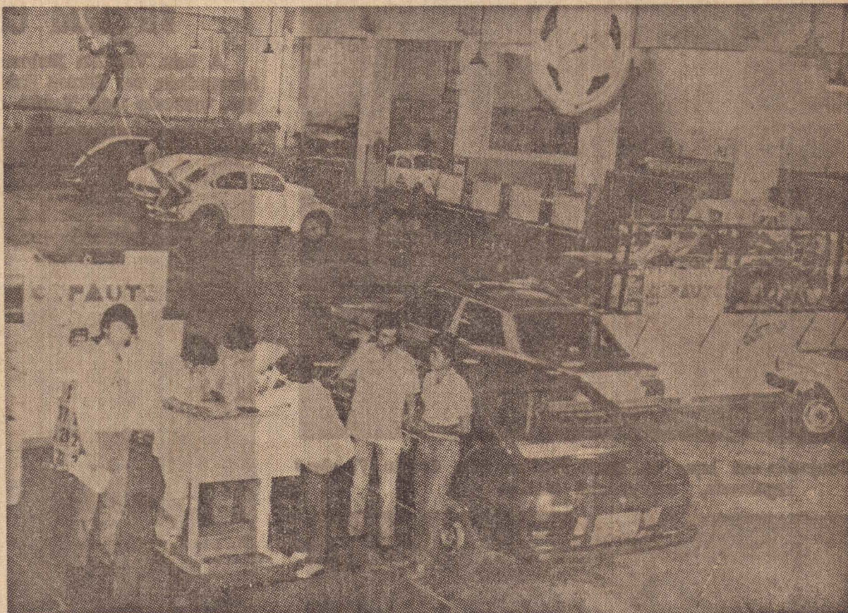
O amplo salão oferece perfeitas condições para os serviços de Mecânica, Funilaria, Pintura, Lavagem, Balanceamento, Alinhamento e Peças.
