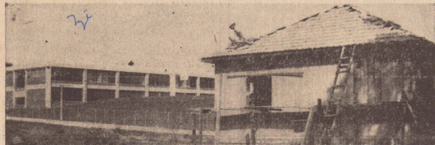
Esta casa de madeira está em fase de conclusão na Vila São Jorge, a pouca distância do novo e moderno Edifício do Colégio "Monsenhor Sarrion" que o FECE acaba de executar. Não é um contraste?
