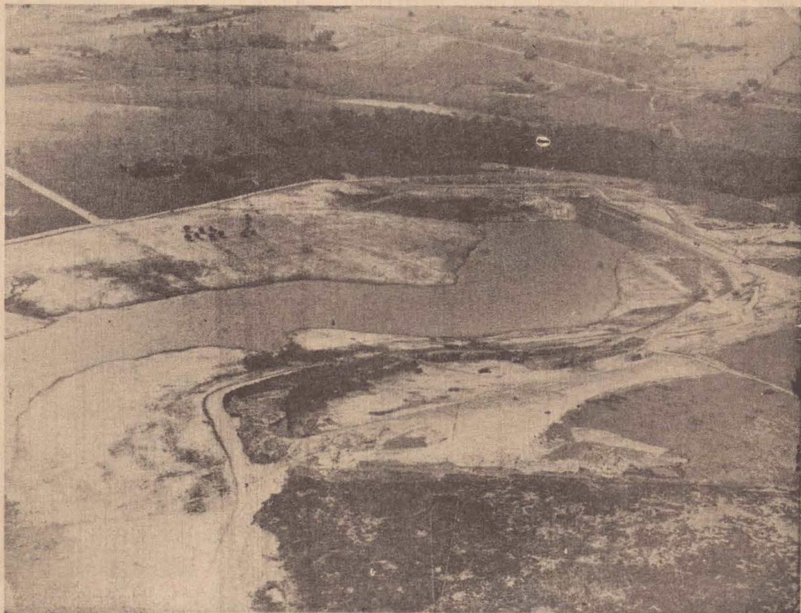
O Balneário da Amizade terá em breve, 25 alqueires de área inundada.
