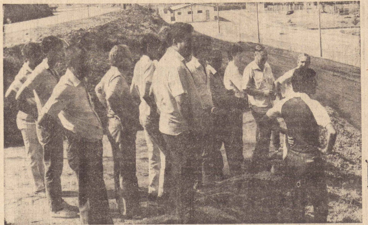
A comissão observando a pavimentação em execução pela Prudente na área dos fundos do recinto de exposições, que ampliou a área de estacionamento. (Foto de André Luiz Azevedo)
