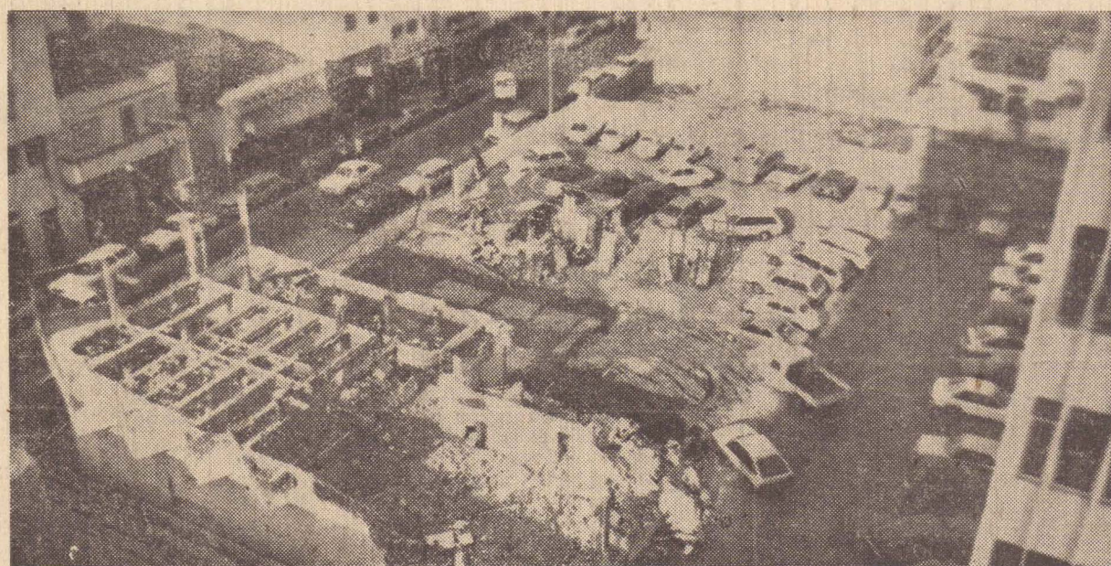
A área total é de 2.000 metros quadrados. Atualmente, está sendo feita a demolição do prédio antigo.
