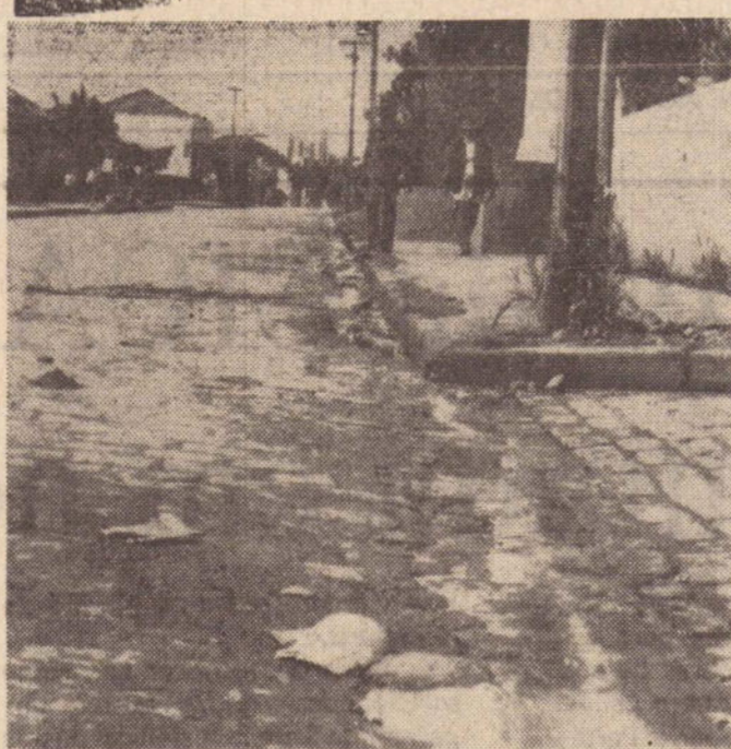
Esgoto, um pedido dos moradores da rua Alvares Machado.
