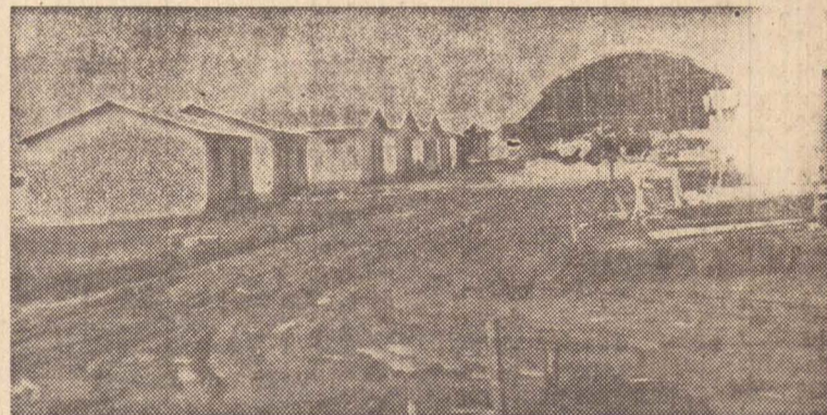
O núcleo habitacional semi-acabado de Pirapozinho agora pode chegar a conclusão de obras
