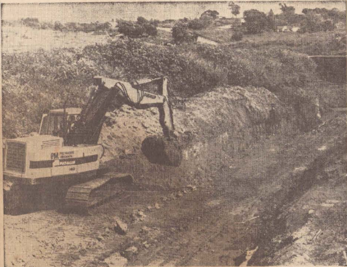
Máquinas em atividades, na "Bacia do Tennis", para a canalização do córrego beneficiando Vilas Santa Helena e Jardim Paulista.
