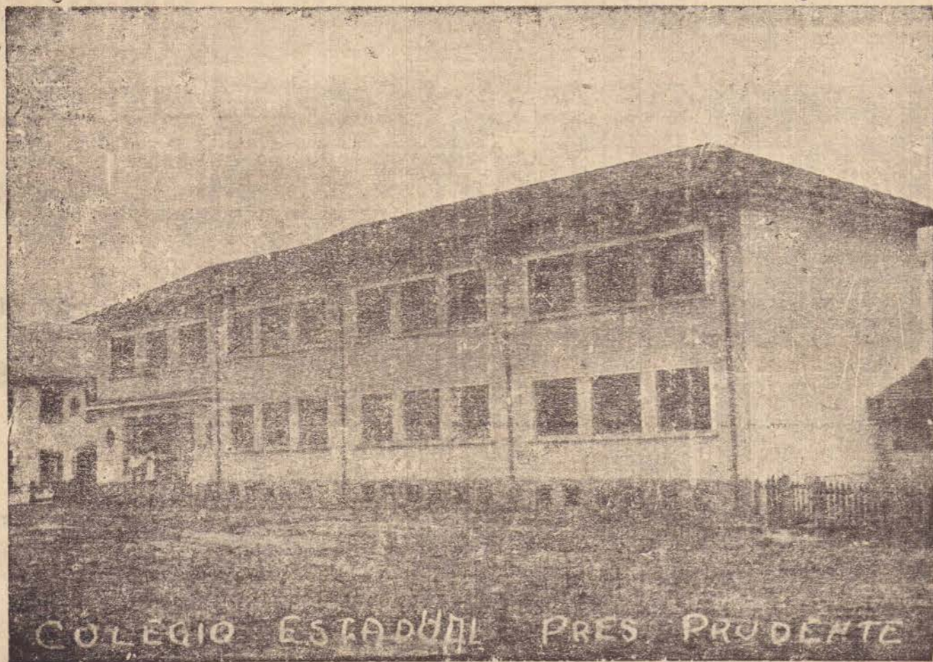
Vista das atuais e acabadas instalações do I. E. Fernando Costa, que abriga mais de 3.500 estudantes
