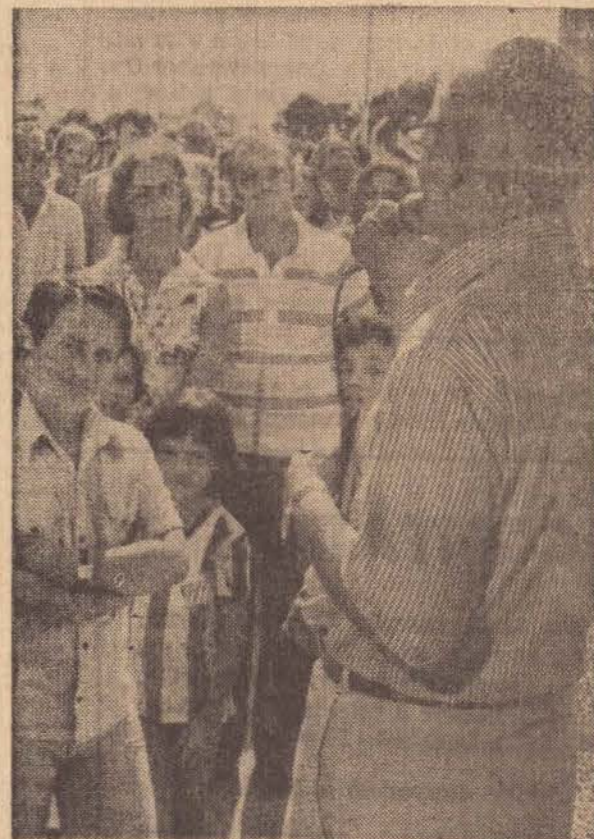
O pe. Heitor, após o desatamento da fita simbólica, procedeu à bênção do novo empreendimento.
