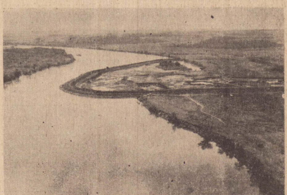
A 55 km. de Presidente Prudente, está sendo construída a USINA CAPIVARA — a maior hidrelétrica do Vale do Paranapanema. Ferro e aço da Siderurgica Dedini S.A. são empregados nessa grande obra.
