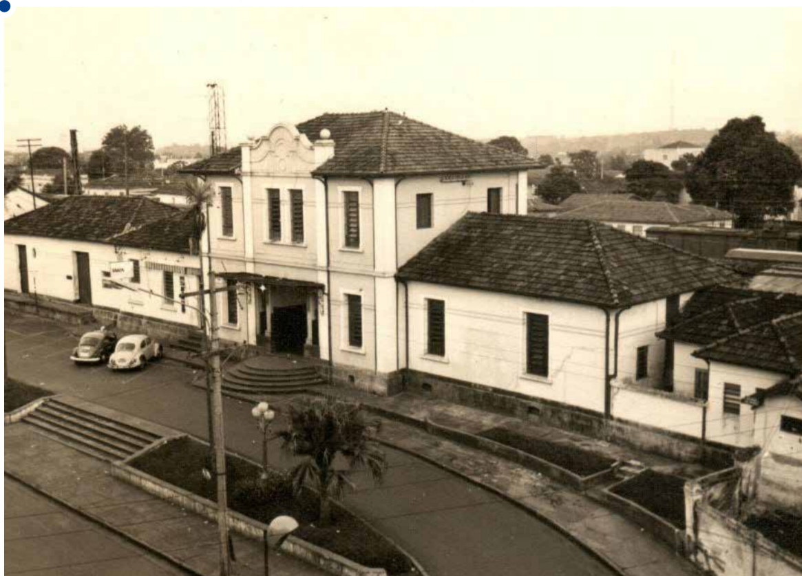
Foto histórica da estação ferroviária de Assis: estudo busca alternativas contra degradação
